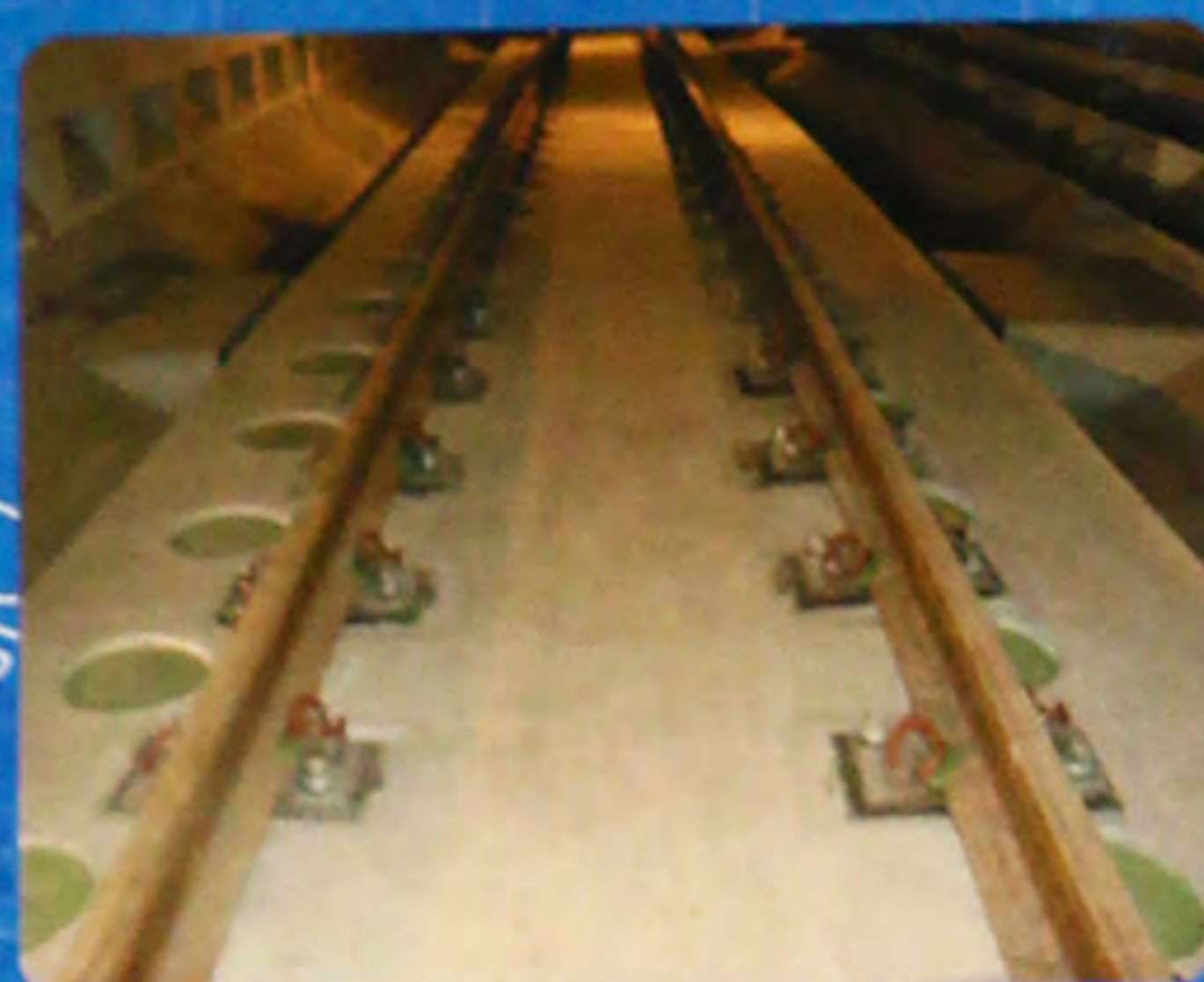
地下鉄軌道防振システム
